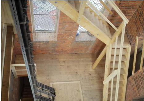
Treppenaufgang in Kirchturm nach der Sanierung
