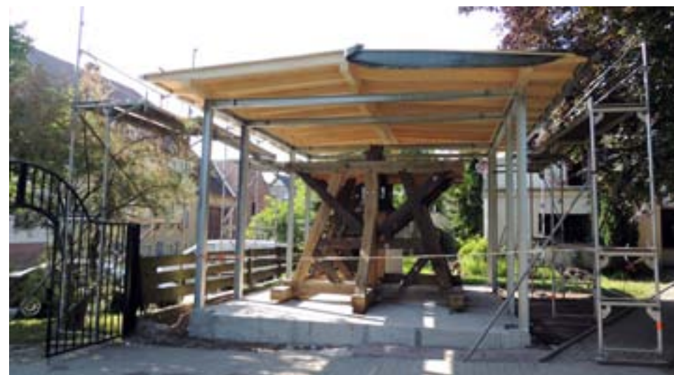
Das Dach für den neuen Glockenstuhl ist fast fertig.
