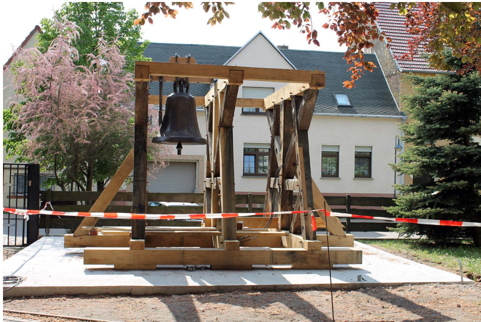
Die neue Bodenplatte ist fertig und auch der sanierte Glockenstuhl steht schon
