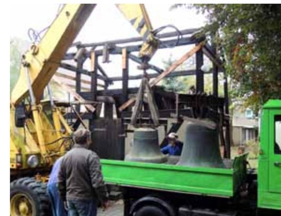
Um nach Jahren nicht noch einmal mit Bauarbeiten anfangen zu müssen und dass die Glocken richtig eingehangen werden können, wird der Glockenstuhl abgebaut und die schadhaften Hölzer, vor allem im Fußbodenbereich ausgetauscht. Eine neue Bodenplatte wird gegossen und der historische Glockenstuhl dann mit Blick zur Straße wieder aufgebaut. Die Überdachung und geplante Umhausung wird danach drum herum gebaut.
