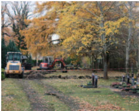
Die Gräberanlage „Grüne Wiese“ wird angelegt
